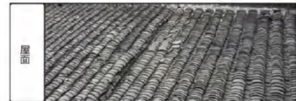
屋面瓦片采用传统小青瓦屋面
