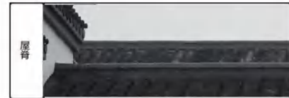
立瓦平脊,中央向两侧,按照传统式样重新处理
