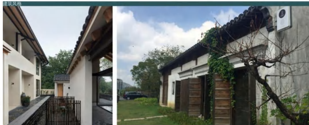
立瓦平脊,中央向两侧,按照传统式样重新处理
